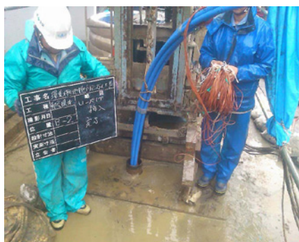
図 12 地中熱設備。熱交換用の U 字チューブの埋設
